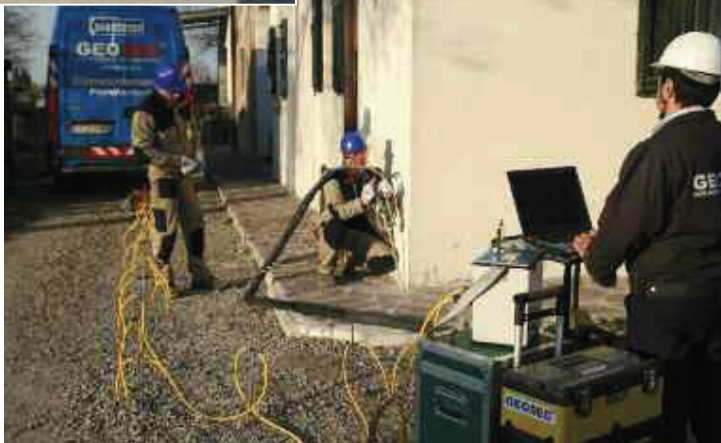
Fase di iniezione sotto controllo strumentale
