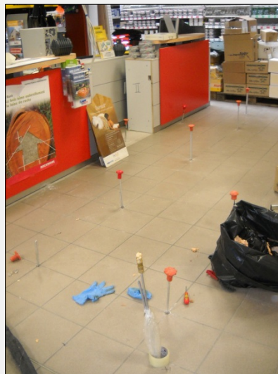
Prédisposition des tuyaux d'injection sous dallage
